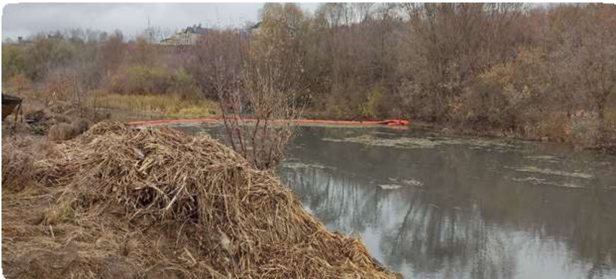
Рис. 1. Боновое ограждение в нижнем створе захватки.
